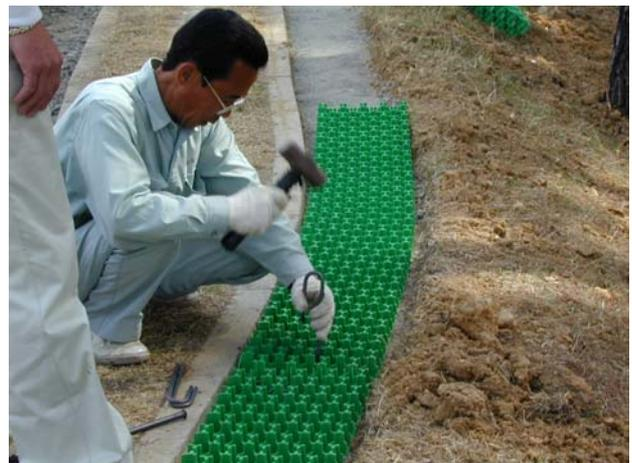
またカーブ部では、カーブ内側から「くさび型」に切り込みを入れ、外側の一部を残してつないでおき、カーブに合わせて曲げて杭で固定している。
