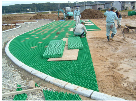
ターフパーキング設置作業
