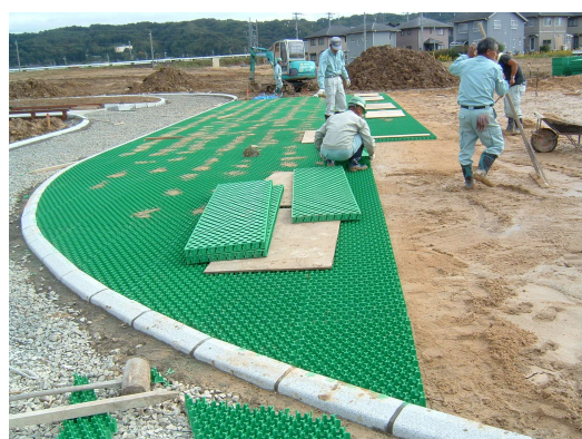
ターフパーキング設置作業
